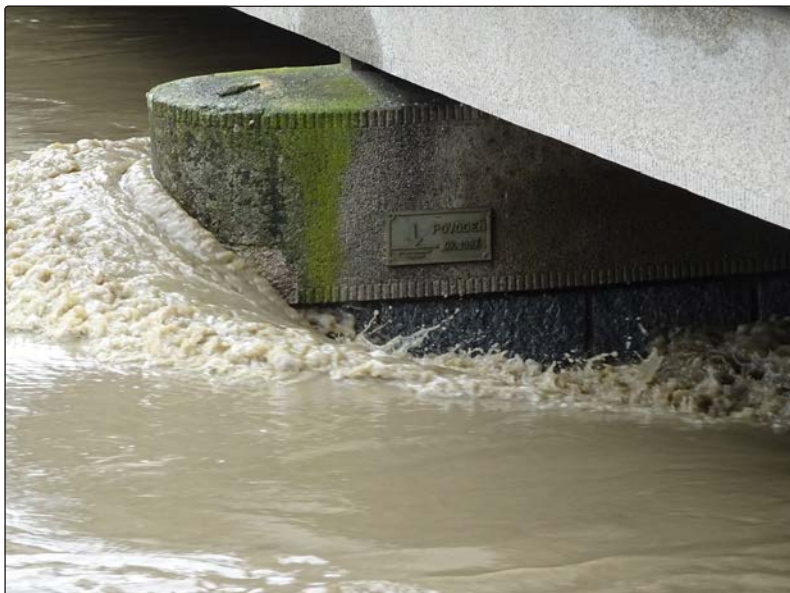
Hladina Olšavy při kulminaci 15. září 2024 (528 cm) a značka z roku 1997. Přesná data z měřicího bodu pod Olšavním mostem jsou k dispozici až od 3. června 2014.
