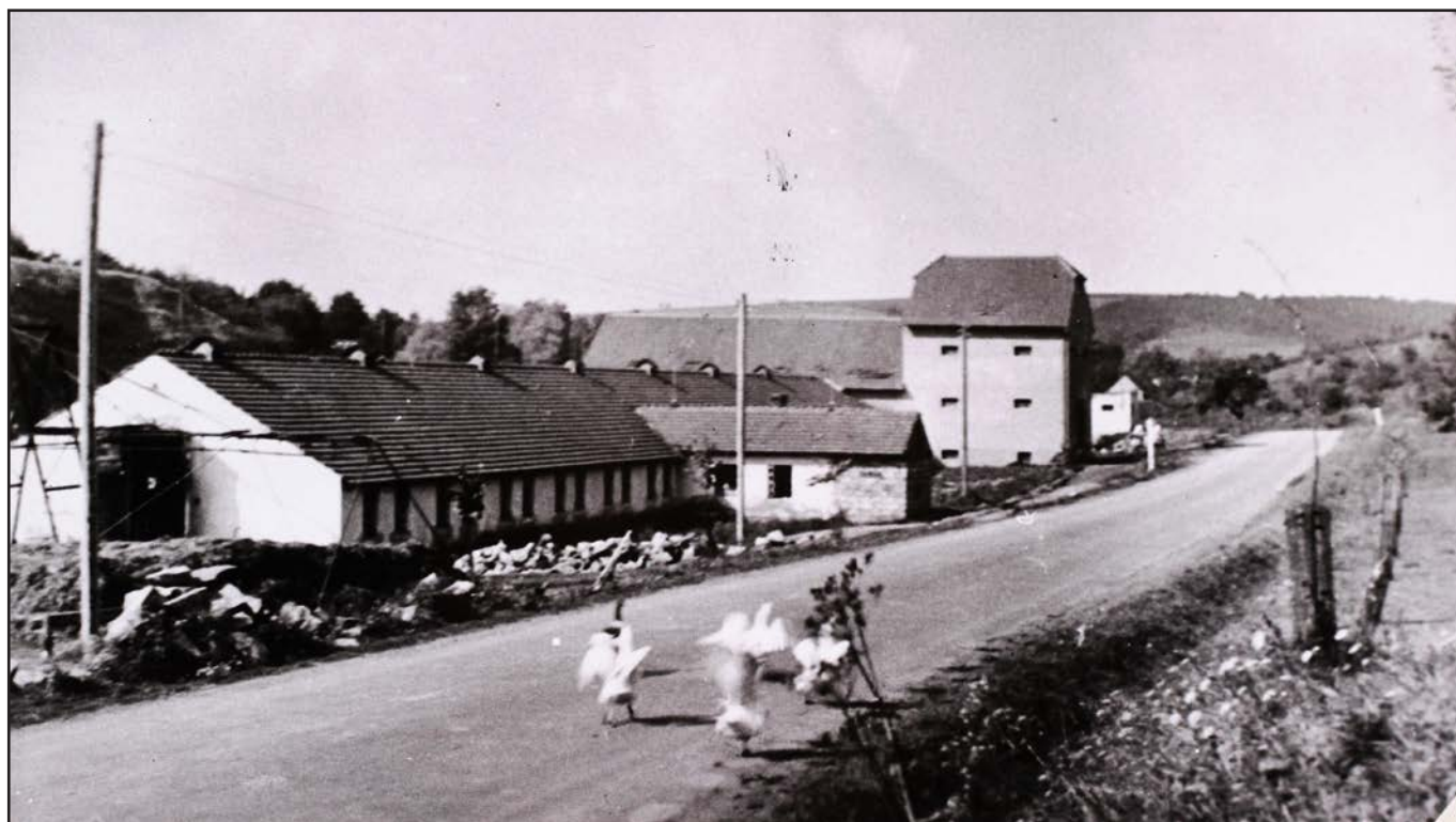
JZD ve Veletinách bylo založeno v roce 1951. První kravín byl stavěn od 5. července 1952, první krávy v něm byly ustájeny v květnu následujícího roku (1953). Při stavbě byl použit materiál ze stájí u zámečku Dr. V. Kounice. Sýpka byla dokončena v roce 1957. Tyto stavby byly z důvodu velmi špatného technického stavu v průběhu letošního roku zbourány. Druhý kravín, který je stále využíván, byl postaven v letech 1965–66.
