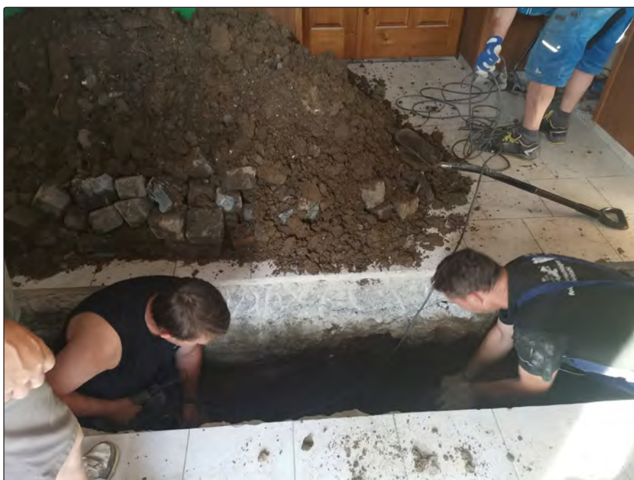
Oprava odpadů v kulturním domě
