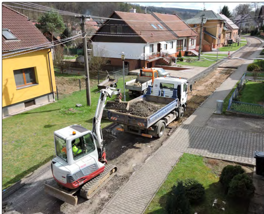
Oprava silnice v ulici Zápotočí
